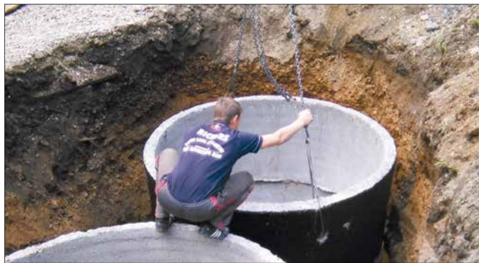
Отремонтирована капитально выгребная яма.
