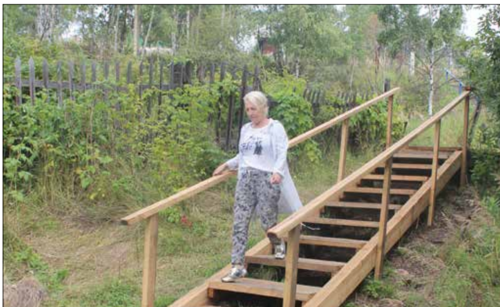
На ул. Академической построили новую лестницу
